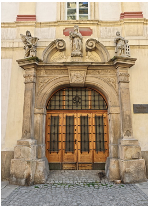
Barokní portál bývalého kláštera dominikánek
