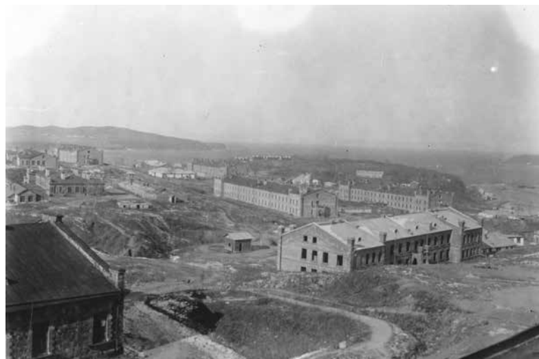
V těchto kasárnách byla ubytována většina legionářů před odjezdem do vlasti (foto VÚA-VHA).
