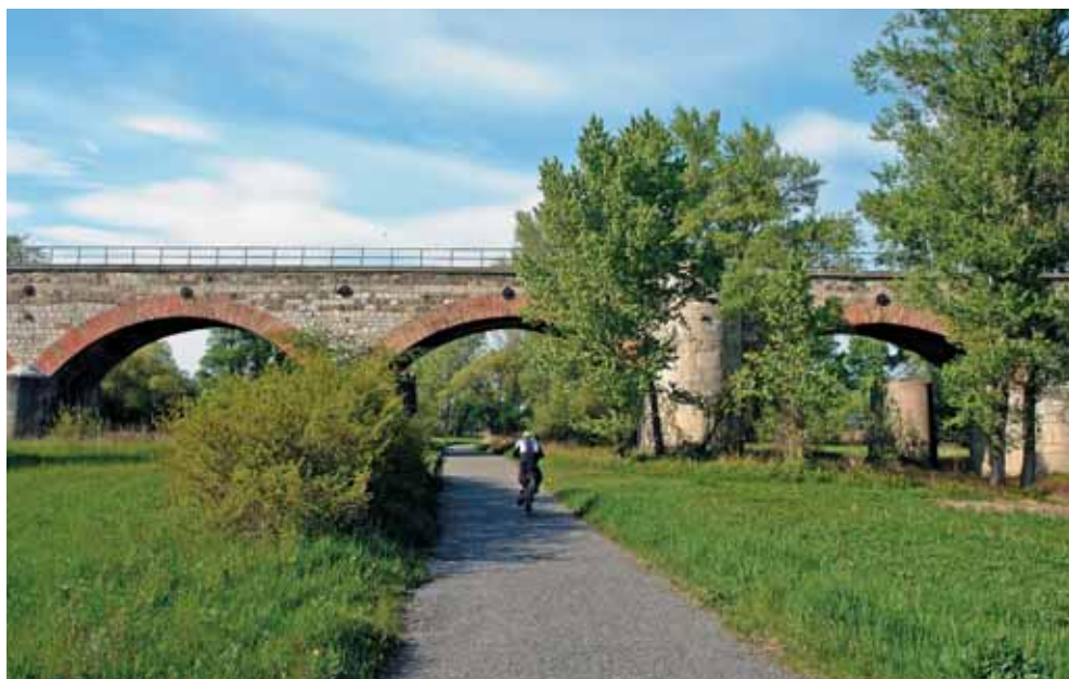
Pri železničnom moste do Marcheggu
