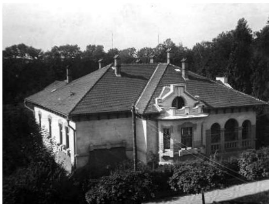
Vila v Kostelci nad Orlicí
