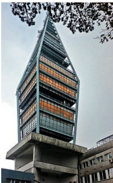
Televízna veža na Kamzíku
