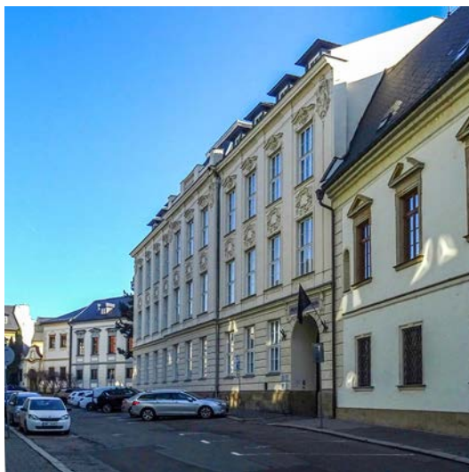
Obr. 1 Hlavní budova FF UP na Křížkovského 10.
