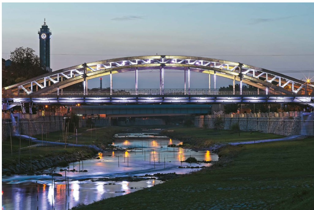
↑ Ostravici překlenuje v centru města ocelový nýtovaný most Miloše Sýkory, který dokončily Vítkovické železárny v roce 1914
