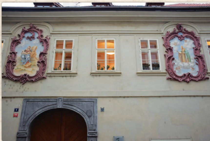
Bývalá toleranční modlitebna (Truhlářská 1113/8)
