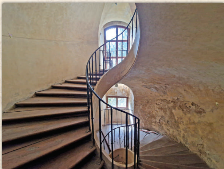
Geniální Santiniho schodiště, propojující kajetánský kostel a klášter
