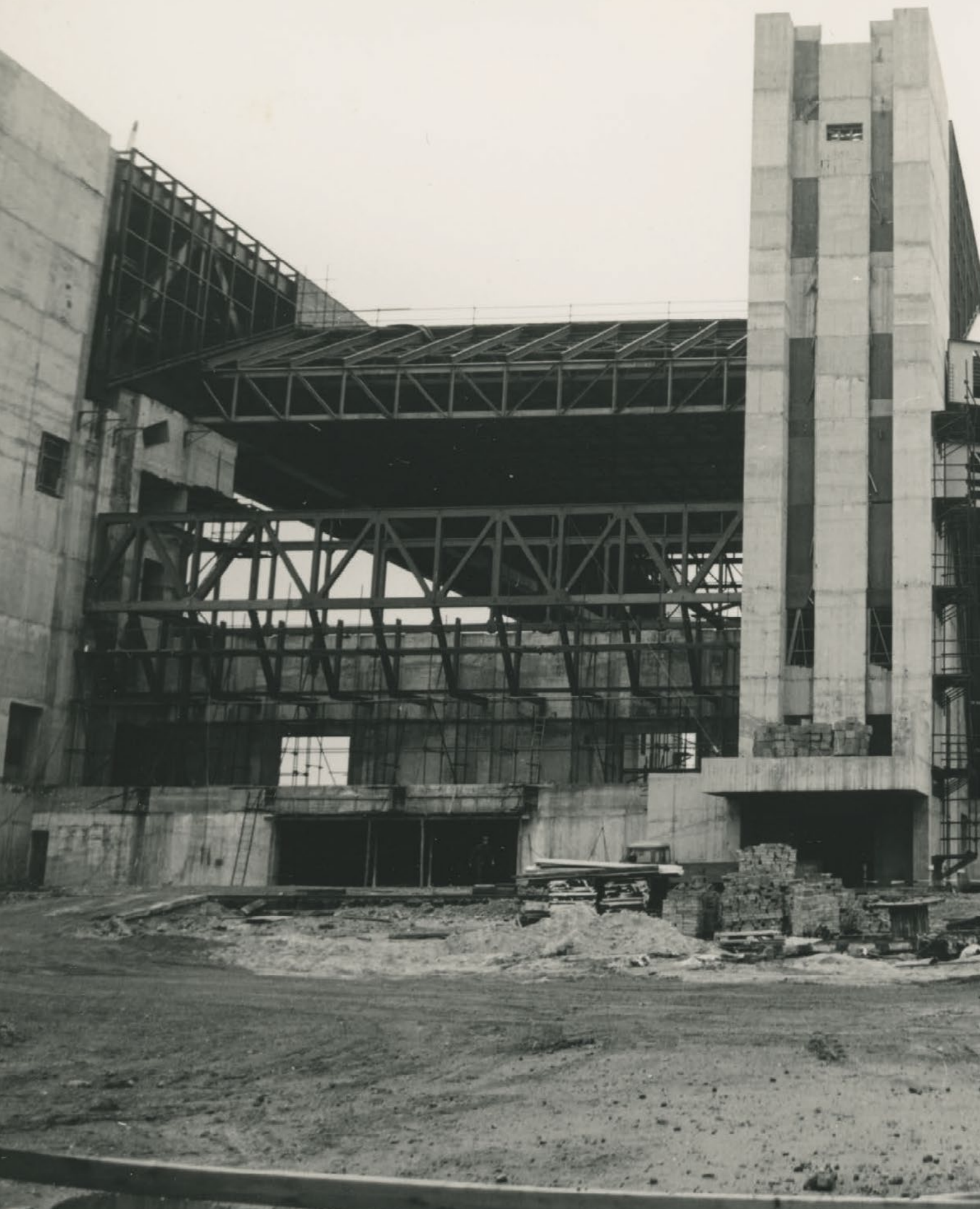
Betonová konstrukce objektu haly ve Vítkovicích
