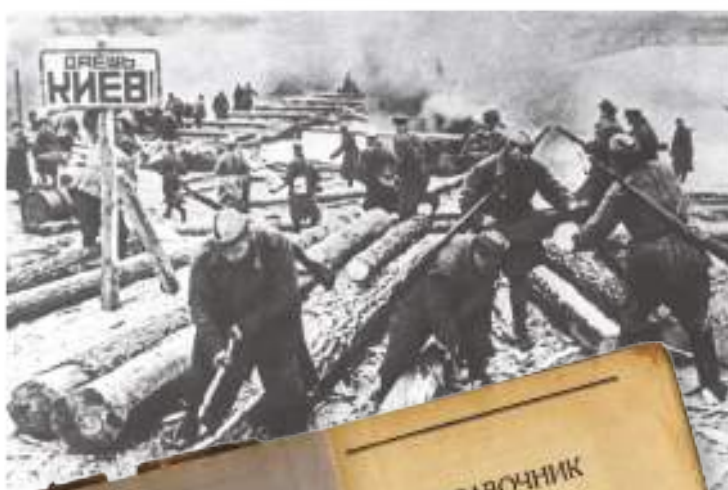
Sovětské ženisté staví provizorní most přes Dněpr
