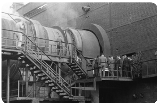
Detail rotační pece.
