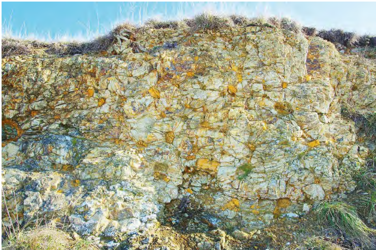
Boční stěna 15. 2. 2017, zachovalejší než stěna čelní
