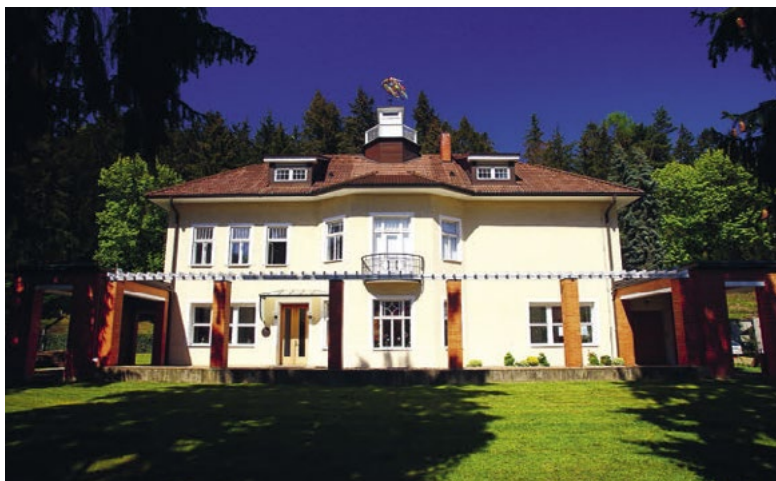
Pohled na jižní fasádu vily Tomáše Bati.
