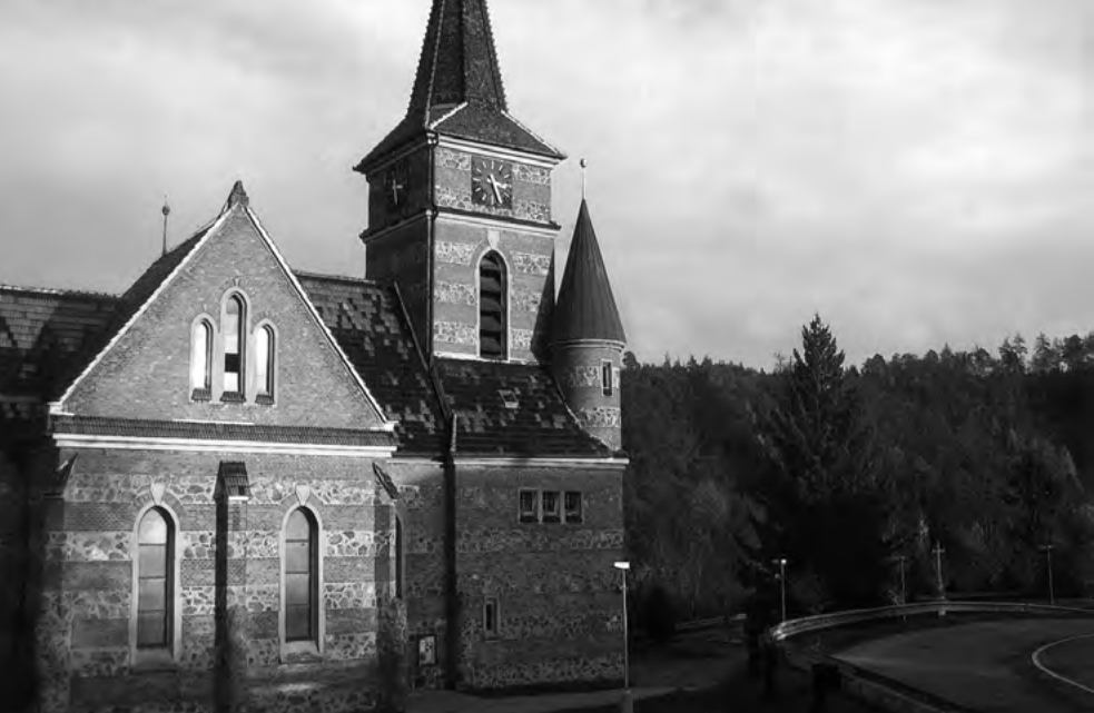
Obnovený kostel v Bílovicích
