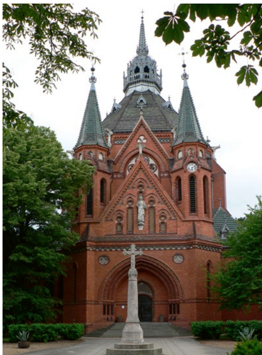
Kostel v Břeclavi – Poštorné
