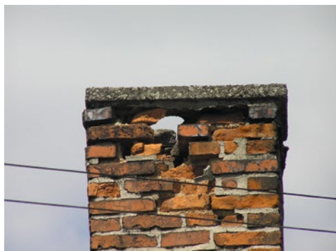
Obrázek 2.16 až 2.19 Příklady poruch způsobených opotřebením materiálu a stárnutím, resp. zanedbanou údržbou
