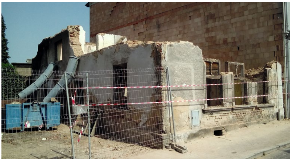
Obrázek 3.1 Ukázka demolice celé budovy
