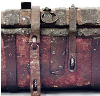
Pásky vyrobené rozkováním železných prutů jsou nejstarším kovářským výrobkem u nábytku.
