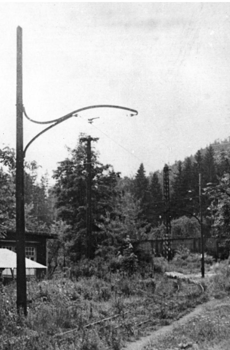
Původní trakční vedení na trati Rybník–Lipno. Archiv EŽ Praha
