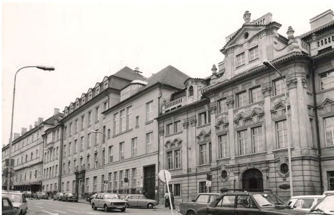
Obr. 1.7 Všeobecná nemocnice s budovou bývalé gynekologie (dnes chirurgie)
