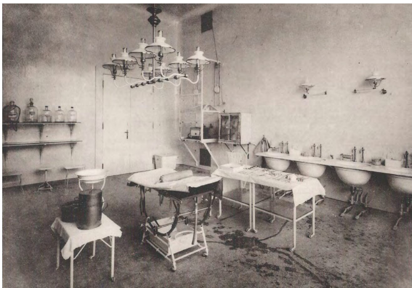
Obr. 1.8 Operační sál německé gynekologické kliniky v Jubilejním pavilonu. Koncem roku 1899 se nastěhovala německá gynekologická klinika do nově otevřeného pavilonu v areálu pražské všeobecné nemocnice, vybudovaného pro čtyři německé kliniky. Kliniky i laboratoře byly vybaveny tehdy nejlepším zařízením.
