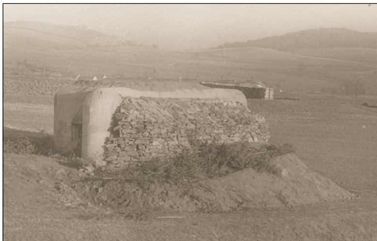
Výřez dobové pohlednice s objektem 197/77/A-180Z, u něhož se stavební firmě nepodařilo dokončit zemní zához. Čelní stěna je tak kryta pouze rovnaninou vyskládanou na sucho z kamenů.
