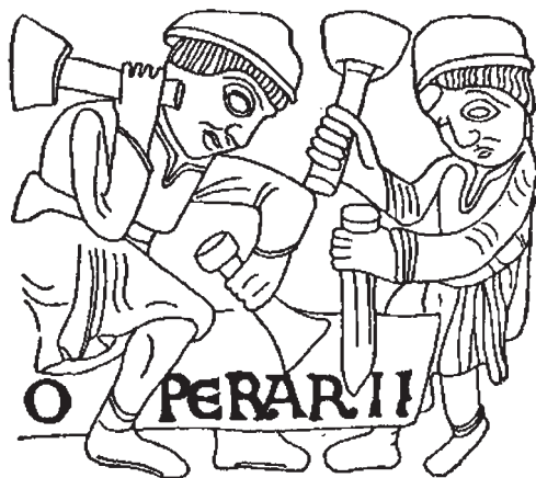
Obr. 2.3 Opracovávání kvádrů pomocí špičáku a plochého (šarírovacího) dláta (románský reliéf z Maastrichtu 1180)
