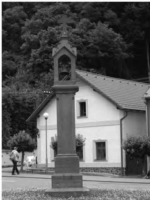
Obr. 3 Jednoduchá sloupová obecní zvonice
