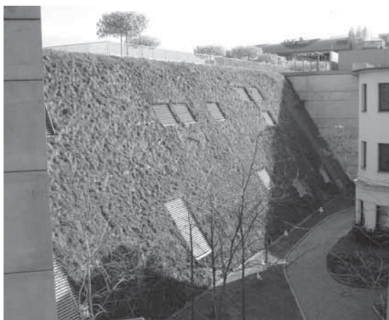
Obr. 1.15 KOC Nový Smíchov, strmá střecha o sklonu 58°, Praha 5, rok 2006
