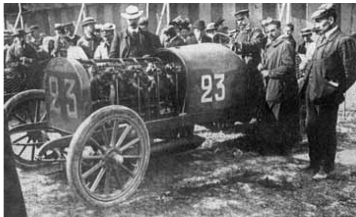
Obr. 2.14 Vůz Pipe řízený Jenatzym v roce 1907 na okruhu v Ardennách, s originální konstrukcí motorů z roku 1904 s rozvodem OHV se dvěma vačkovými hřídeli a s šikmými ventily
