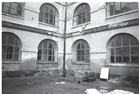
Obr. 1.2 Příklad působení vztlínající zemní vlhkosti
