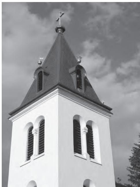
Obr. 1.10 Příklady aplikace větracích žaluzií v historických objektech
