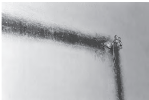
Obr. 1.5 Typickým projevem povrchové kondenzace je orosování povrchů konstrukcí, v tomto případě „obkreslování“ rozvodů studené vody s následným výskytem plísně
