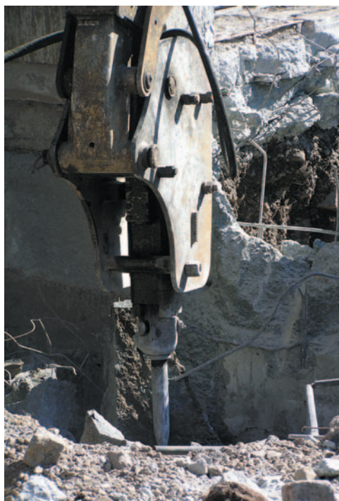
Obrázek 3.2 Bourání pneumatickým kladivem
