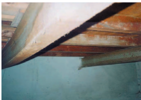
Obrázek 2.1 Nadměrný průhyb stropního trámu
