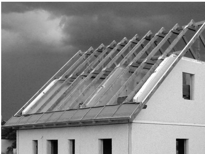
Obr. 3 Krov opatřený nátěrem
