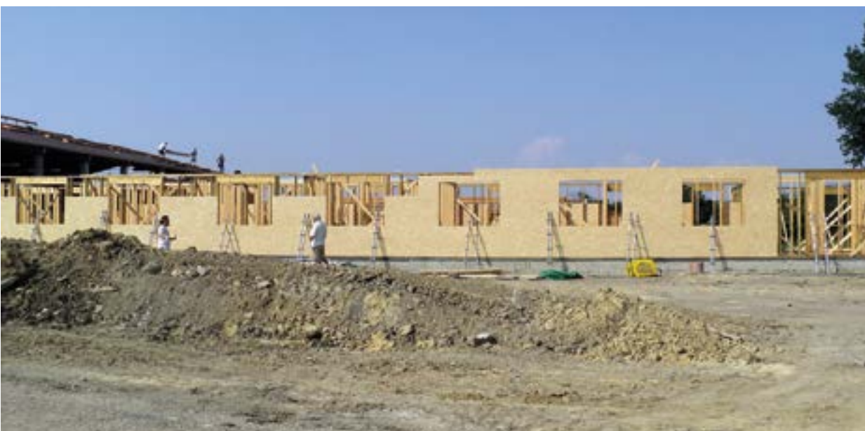
Obr. 1.1 Základní fošnová konstrukce TBF, na horním obrázku zatím bez opláštění deskami OSB. Deskový ztužující efekt nahrazuje provizorní diagonální zavětrování. Na pravém obrázku se opláštění provádí z vnější strany a spolu s rámem stěny.
