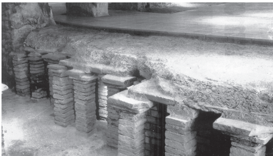
Obr. 3.2 Starořímské Hypokaustum – použití čtvercových cihel pro tvorbu spalinových dutin
