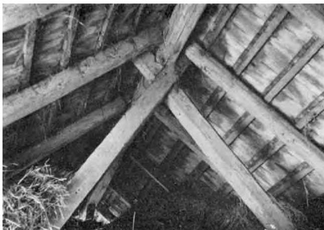
Ostružno (u Sušice), č. 2 [Mencl, 1980] Střecha sýpky na kobyly podepřenou nůžkami, sklon 40°
