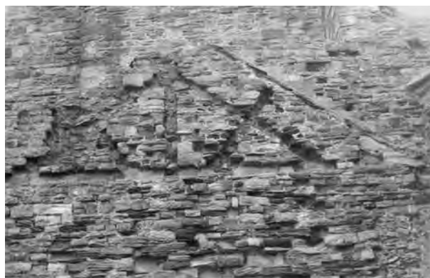
hrad Tantallon (Skotsko), otisk krovu ve štítové zdi, sklon 35°
