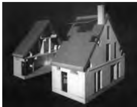
Obr. 4 Model kombinovaného systému domu ze sekci zděných štítů doplňovaných prefabrikáty stropů a střešních panelů na bázi dřevostavby
