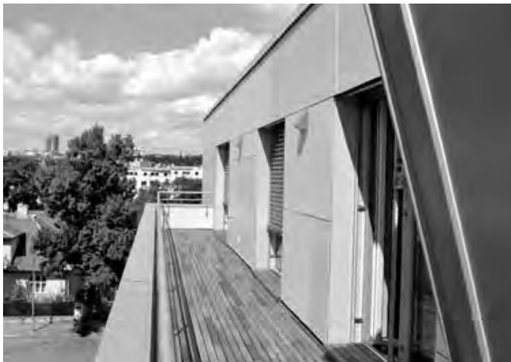
Obr. 17 Povrch fasády s obkladem cementovláknitými deskami je zavěšen na kotvy z laminátových profilů s podložkami Compactfoam s omezením tepelné vazby
