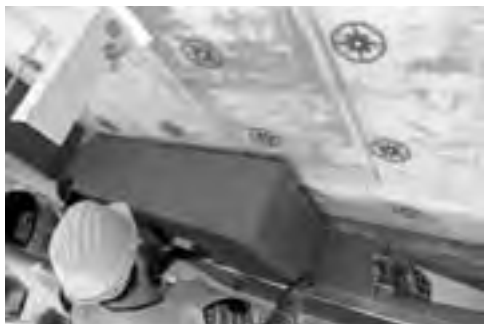
Obr. 19 Laminátová konzola a zateplení 280 mm pěnového polystyrenu s přísadkou grafitu
