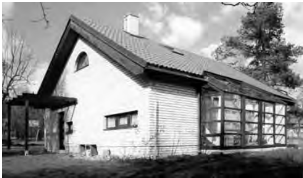
Obr. 10 RD u Mníšku pod Brdy s první reálnou zkušeností s šikmou nestíněnou prosklenou plochou zimní zahrady, zateplený izolací Climatizer Plus v tloušťce 120 mm
