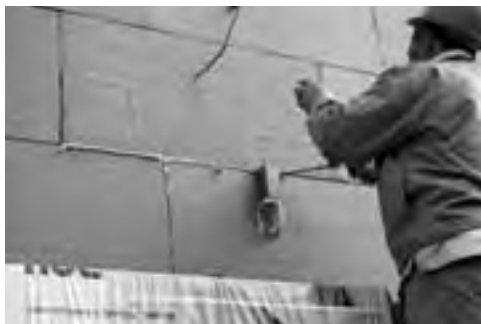
Obr. 20 Nezbytné pečlivé zaplnění všech dutin PUR pěnou
