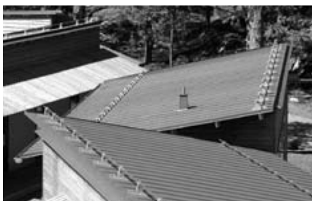
Obr. 2.2 Pultová střecha – foto a schéma (objekt s plechovou krytinou Ekskåret norrtailje, zdroj: Rhein-zink ČR, s. r. o.)
