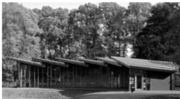
Obr. 2.8 Pilová střecha – foto a schéma (objekt Avenham Park Pavilion, Preston, Velká Británie, zdroj: Rheinzink ČR, s. r. o.)
