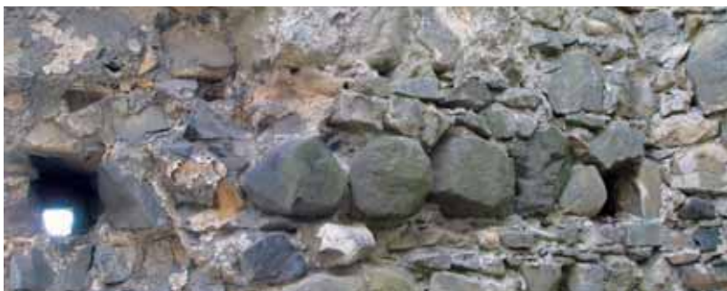
Nepravidelné zdivo hradu Valečov je postavené jak z lomového kamene, tak z přitesaných kvádrů.
