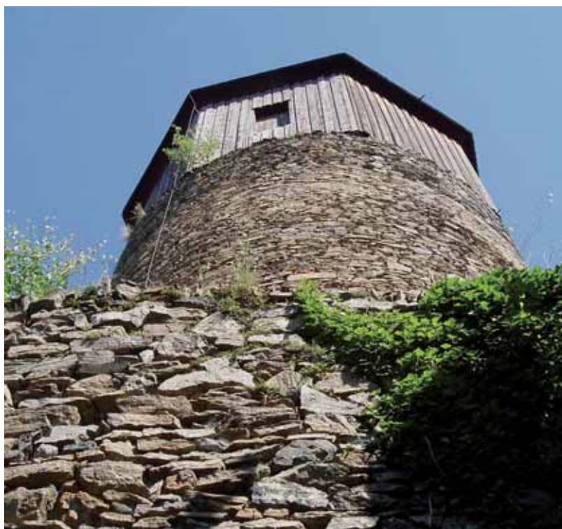
Přitéšované drobové a břidličné kvádříky ve zdivu hradu Pirkenštejn.
