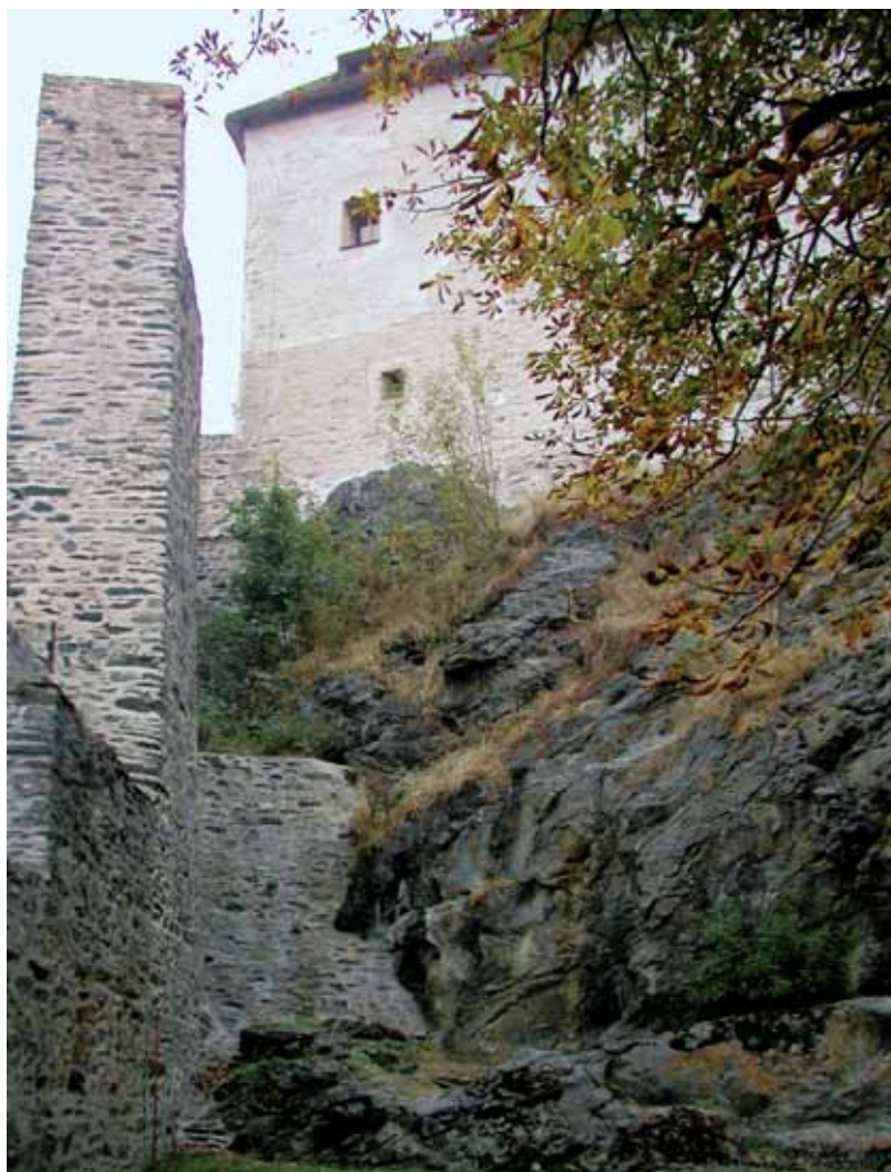
Přitesané rulové a amfibolitové kvádry tvoří zdivo hradu Kámen.
