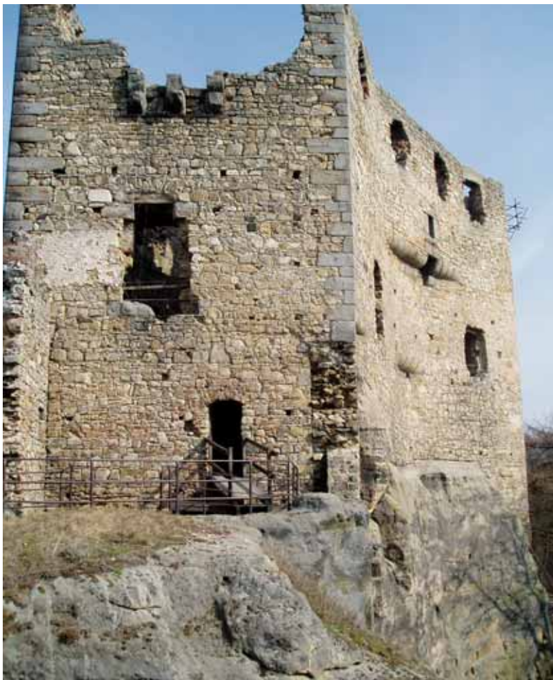
Pískovcové bloky použité k armování nároží hradu Valečov.
