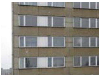
Obr. 3 Použití meziokenních vložek u panelového domu; názvosloví
