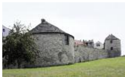
Bašty městského opevnění (Louňy)
