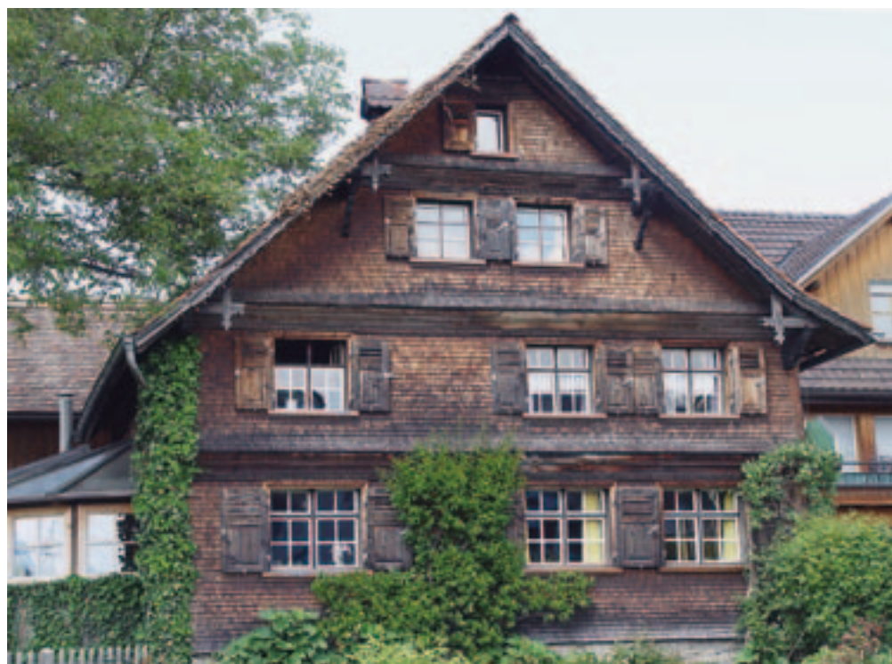
Obr. 1.9 Dřevěná fasáda ve Vorarlbergu. Fasáda z dřevěných šindelů umožňuje krýt poschodové římsy, což chrání okna před vlivy počasí. Velký přesah střechy způsobuje typicky různý stupeň zešednutí.
