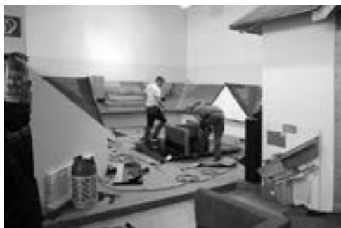
Obr. 1.002 Praktická část zkoušek izolačních firm
