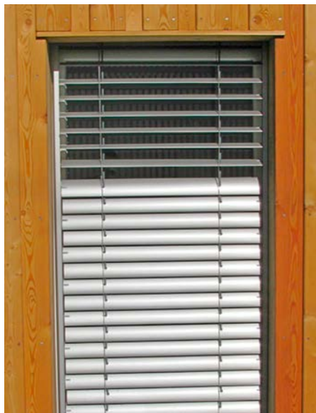
2-20 Stínění dělenými žaluziemi s nastavitelným sklonem, kde horní část odráží světlo na strop místnosti (Foto: Jan Neuwirt)
