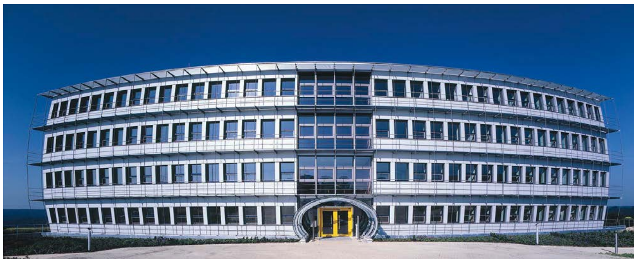
2-11 Administrativní budova Energon (Architektura a foto: oehler faigle archkom)
