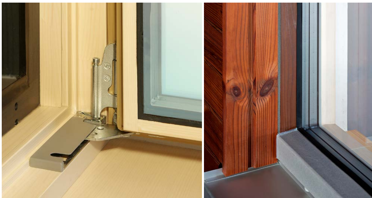
2-14 Skryté kování a osazené okno kompletně schované v izolaci (Foto: Slavona)
