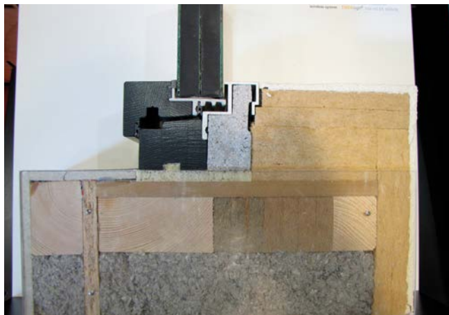
2-18 Osazení moderního nízkého rámu okna do dřevostavby v místě ostění (Foto: autor)
