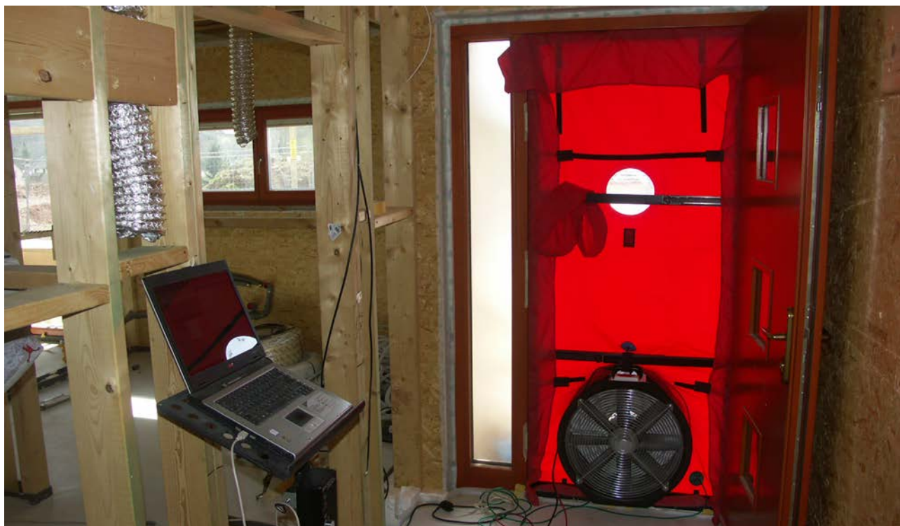
2-24 Test těsnosti v průběhu výstavby po dokončení vzduchotěsnicích opatření (Foto: Stanislav Paleček, Radion)
