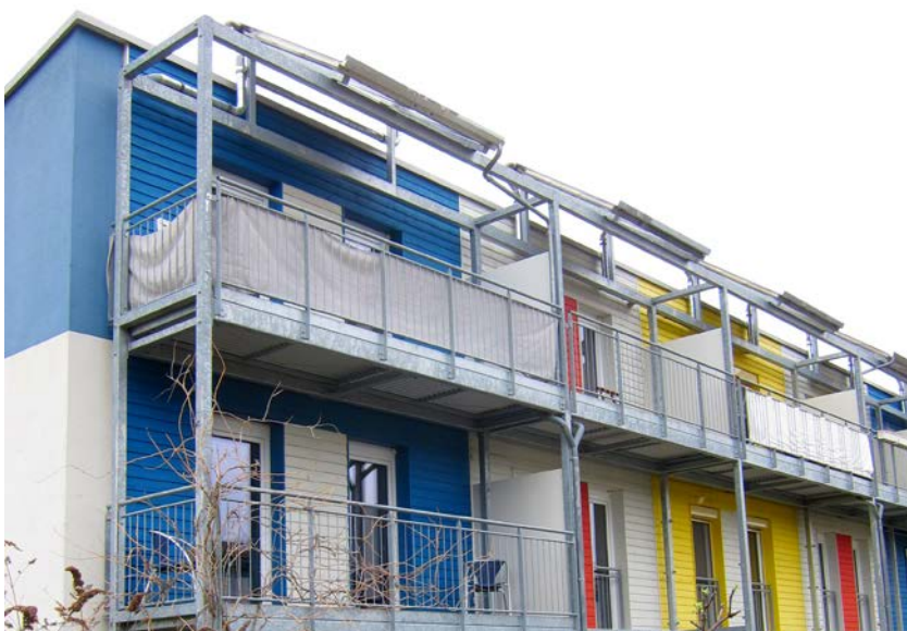
2-23 Pro jižní okna jsou výhodné horizontální stínící prvky, které mohou současně sloužit jako balkony, s případnou integrací solárního systému (Foto: autor)
