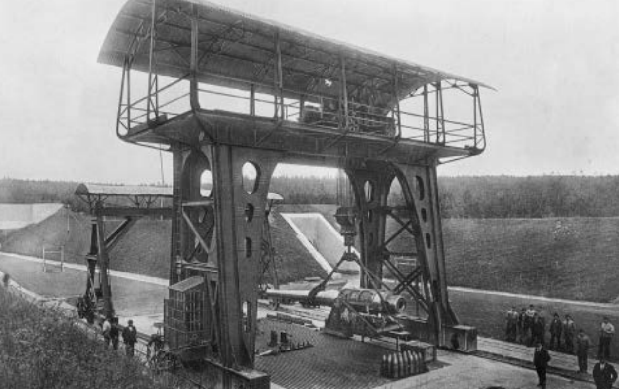
Jeřáb o nosnosti 80 tun, schopný zdvihat i nejtěžší děla na střelnici v Bolevci
