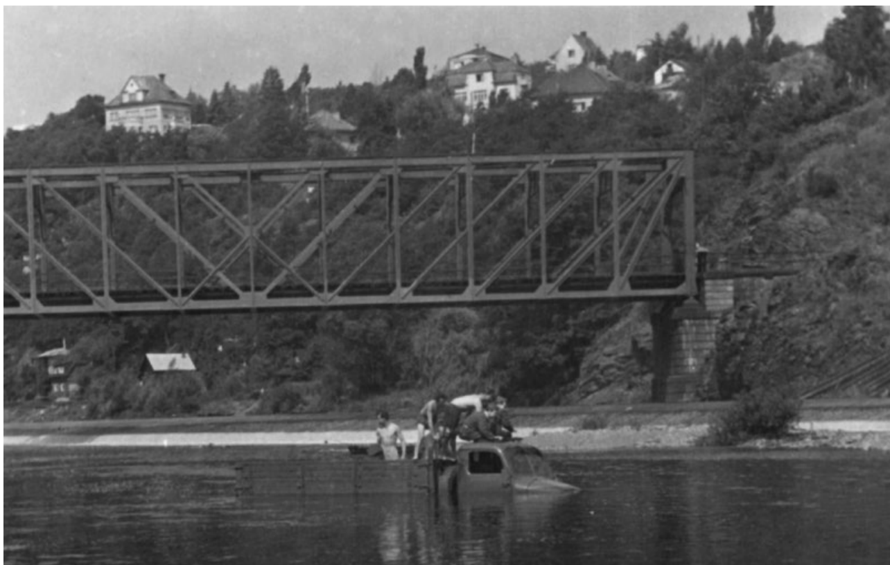
Záběry z výcviku hlubokého brodění 1. autopraporu na řece Berounce v obci Mokropsy pod jezem u železničního mostu (trať Praha – Beroun) v létě 1954
