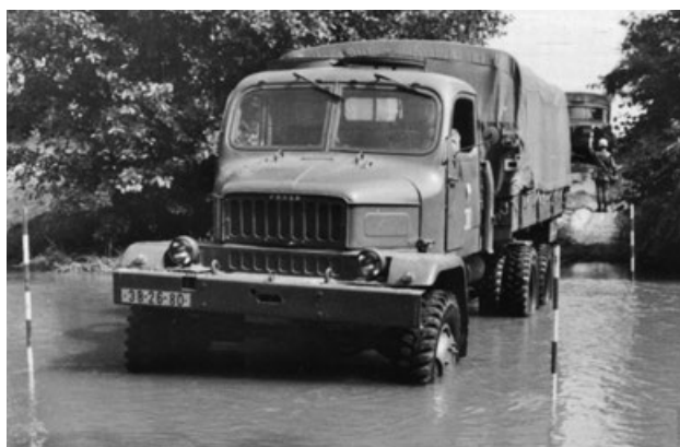
V3S při překonávání vodního toku, brod označen červenobílými výtyčkami
