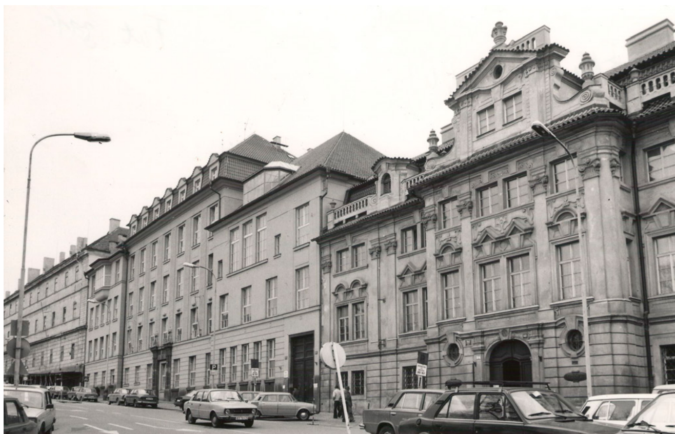
Obr. 2.7 Všeobecná nemocnice s budovou bývalé gynekologie
