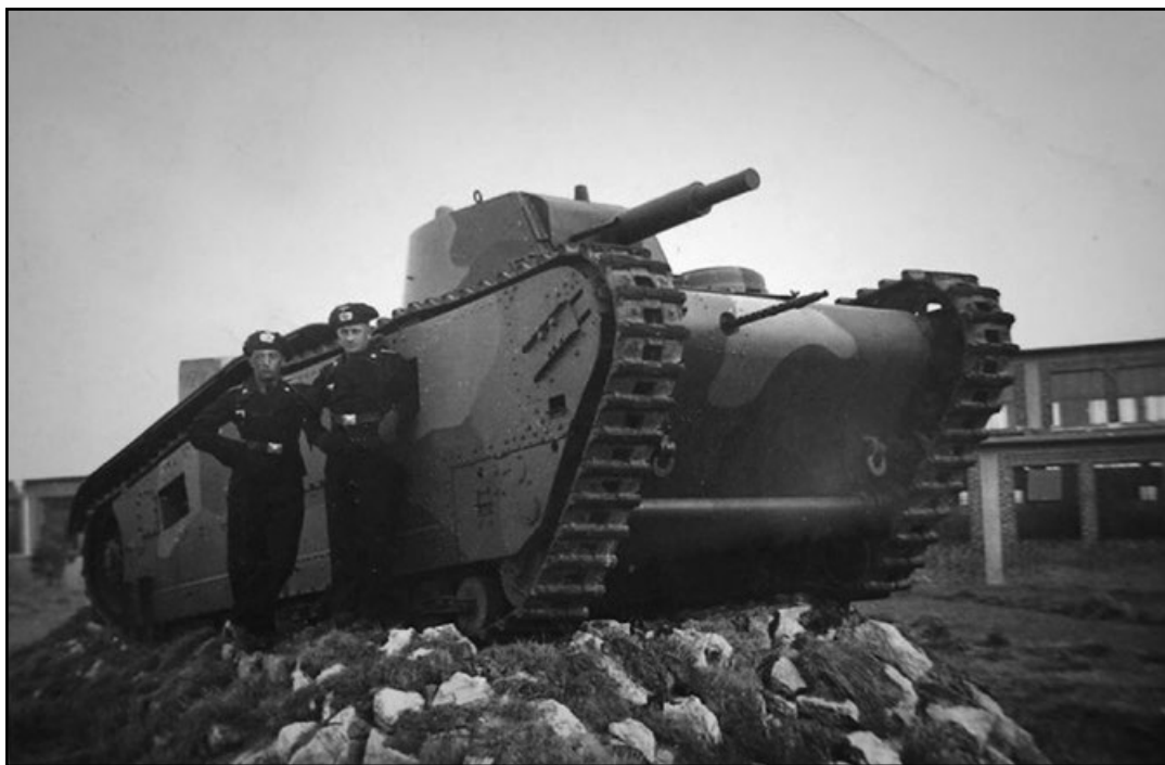
▲ Grosstraktor (velký tahač) byl střední tank, který v letech 1929 a 1930 vyrobily po dvou kusech tři různé společnosti: Krupp, Rheinmetall-Borsig a Daimler-Benz. Vozidla byla z nepancéřované oceli o tloušťce 13 mm a hlavní zbraní byl kanón ráže 75 mm. V rozporu s Versailleskou smlouvou se v Sovětském svazu s Grosstraktorem prováděly utajované zkoušky, při nichž vyšlo najevo pouze omezené operační využití. Na snímku je jeden z tanků Krupp, vystavený u 5. obrněného pluku v německém Wünsdorfu. Z přední části vyčnívá kulomet. Bundesarchiv
