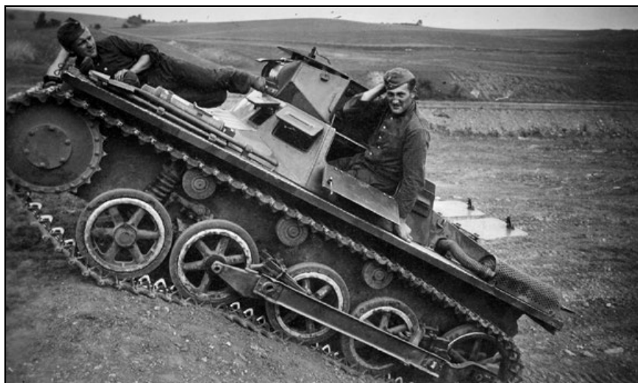
▲ Panzerkampfwagen I Ausf A, vyráběný společnostmi Henschel, MAN, Krupp-Gruson a Daimler-Benz, byl prvním sériově vyráběným německým tankem. Jednalo se o dvoumístný lehký tank, v jehož věži byly integrovány dva kulomety MG13 ráže 7,92 mm. Jeho pancíř měl tloušťku od 6 mm do 13 mm. Výkon zajišťoval motor Krupp M305 prostřednictvím převodovky s pěti rychlostními stupni vpřed a jedním vzad. Od července 1934 do června 1936 se vyrobilo celkem 818 kusů. Stroj na snímku je Panzerkampfwagen I Ausf A z počátku výroby. Kulomety byly demontovány. Patton Museum
