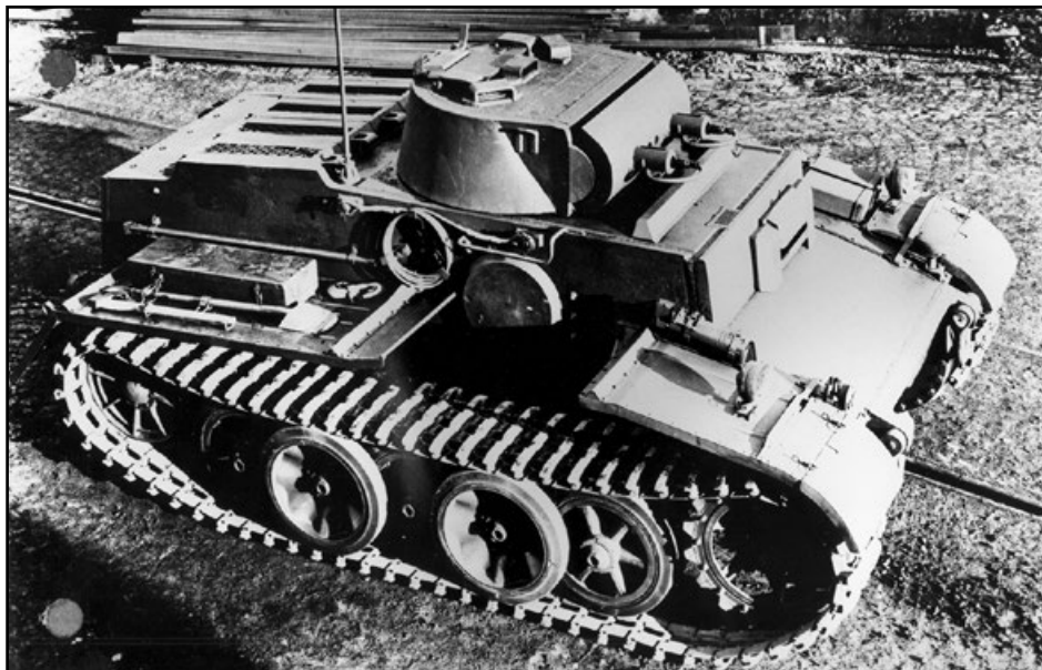
▲ Na střeše korby v přední části věže Panzerkampfwagen I Ausf F navržené firmou Daimler-Benz byla nápadná zástěrka. Velitel a střelec měli k dispozici pět periskopů. Blatníky po obou stranách vozidla jsou přerušené, aby vznikl prostor pro kulaté příklopy na bocích korby. Společnost Krauss-Maffei vyrobila od dubna do prosince 1942 celkem třicet těchto vozidel. Patton Museum
