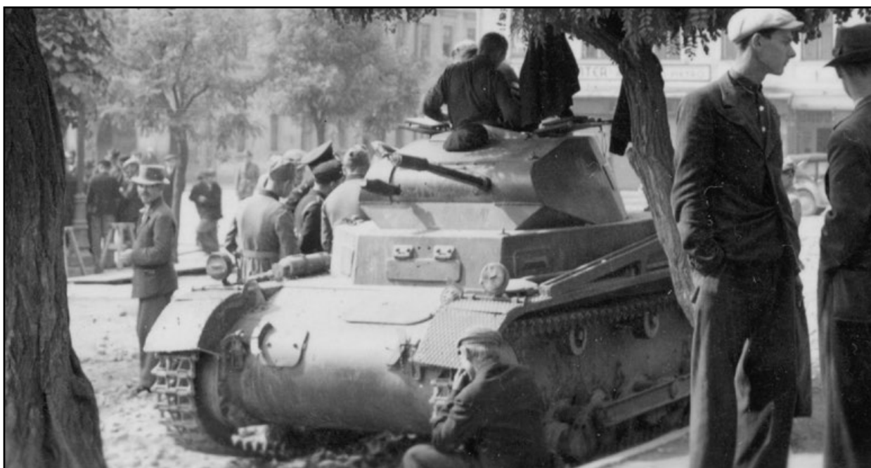
▲ Druhým vývojovým modelem vozidla Panzerkampfwagen II byl Ausf b. Firma MAN jich v únoru a březnu 1937 vyrobila sto. Tento tank byl podobný Ausf a, ale měl nová hnací kola a nosné kladky, širší pojezdová kola, zesílené zavěšení kol, vylepšené odvětrávání motorového prostoru a sklápěcí zadní blatníky. Pancéřová ochrana zůstala stejná jako u Ausf a, kromě mírně silnějšího pancíře na horní a spodní straně věže a korby. Snímek tohoto tanku Panzerkampfwagen II Ausf b byl pořízen v neznámém městě. Patton Museum
