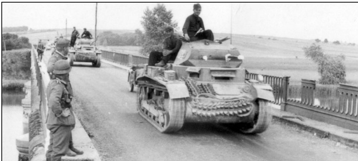
▲ Dvě vozidla Panzerkampfwagen II Ausf a z Panzer Regiment 1 přejiždějí most při invazi do Francie 15. června 1940. Obě vozidla mají protisluneční clony přes průzory řidiče. Na střeše věže je viditelná maketa periskopu, dále také řidičův příklep v nárazové zóně před průzorem řidiče. National Archives and Records Administration
