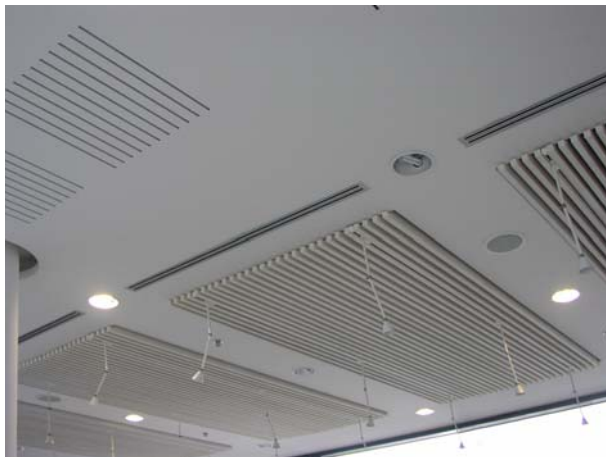
Obr. 4.11 Štěrbínové desky v kombinaci s frézovanými deskami
