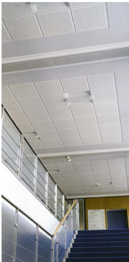
Obr. 4.19 Kombinace hladkých a děrovaných sádrokartonových kazet; hladké odráží zvuk, děrované ho naopak pohlcují
