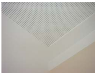
Obr. 4.14 Příklad přímého kruhového děrování
