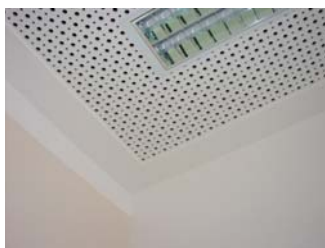
Obr. 4.13 Příklad kruhového přesazeného děrování
