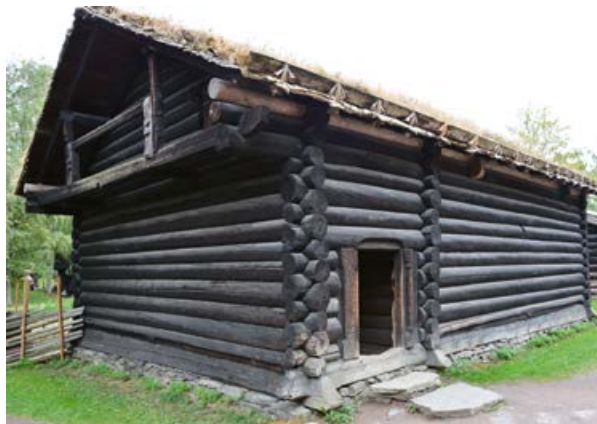
Obr. 14, 15 Raně středověký dům ze Søre Rauland v údolí Uvdal, postavený podle posledního datování kolem roku 1238 a dnes přenesený do muzea v Oslo, je nejstarší známou dřevěnou obytnou stavbou na světě. Pozoruhodný je vstupní portálek, vroubený románskými polosloupky s ornamentální řezbou. Konstruktivní řešení nároží stavby je podobné raně středověkým domům z Pražského hradu.
