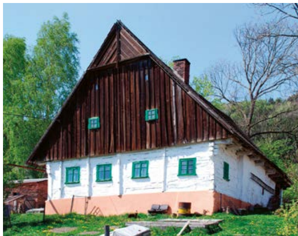
Obr. 32 Příklad přízemního roubeného obytného stavení – domu, s nabilenými stěnami světnice a vysokou lomenicí (Bělý, Policko).
