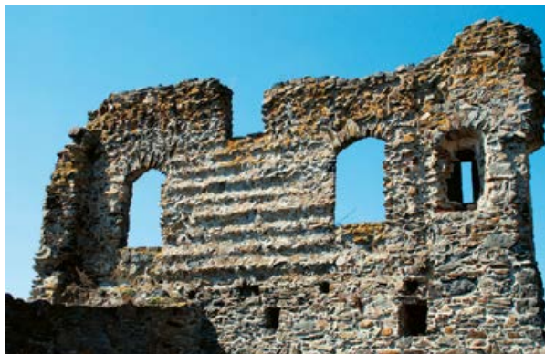
Obr. 23 Otisk stěny středověké roubené obytné místnosti. Srub vložený do kamenných zdí měl v tomto případě funkci zateplení (zřícenina paláce hradu Borotín na Táborsku).
