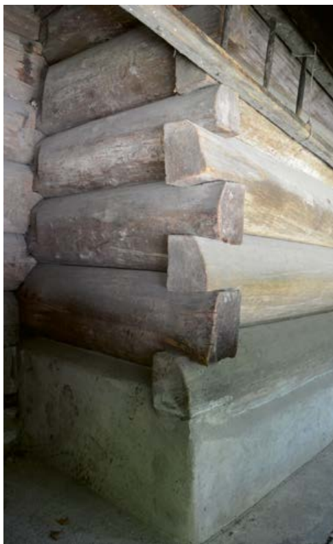
Obr. 11 Rohové spoje půlkulatých srubových trámů s vnitřním zámkem na nároží lodi kostela v Gutech u Třince z 16. století, vypáleného v létě 2017.
