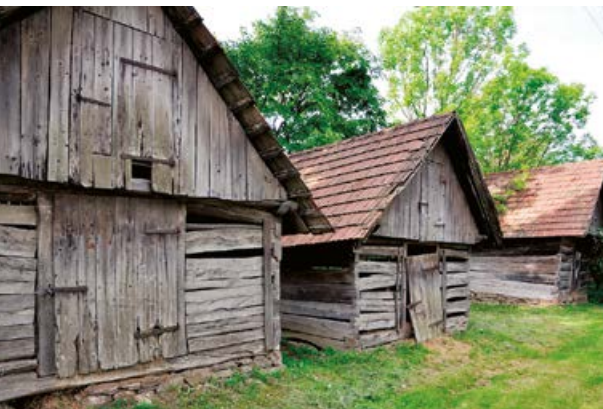
Obr. 45 Řádka seníků se srubovými stěnami z dubového dřeva (Javorník, Bílé Karpaty).
