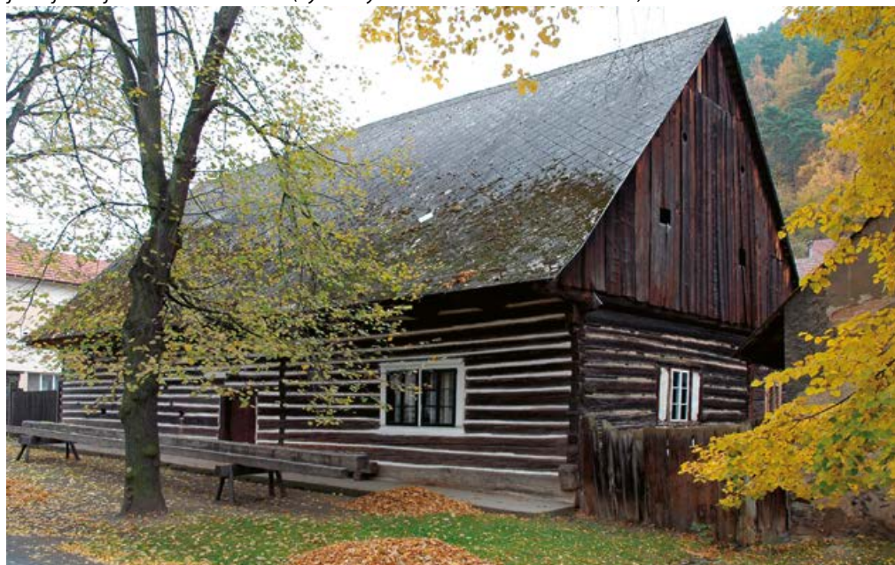
Obr. 21 Další ze starobyklých roubených domů v Čechách, s typickým špýcharovým uspořádáním, i když jizba je zde již nahrazena světnicí (bývalá rychta ve Zbečně na Křivoklátsku).
