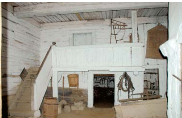
Obr. 22 Mimořádně působivé vnitřní uspořádání síně přes dvě podlaží s vnitřní pavláčkou umožňující vstup do patrových komor v zadní části domu (bývalá rychta ve Zbečně na Křivoklátsku).
