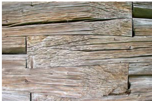
Obr. 9 Mistrné provedení i těch zcela účelových staveb ukazuje na virtuozitu dávných tesařů. Na snímku rybinové pláty stěn roubené polygonální stodoly – navazující stěny tedy nejsou navzájem kolmé! Přestože tesaři nejčastěji pracovali jen s provázkem a sekerou, je sesazení trámů dokonalé (Čistá, Litomyšlsko).
