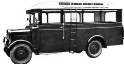
WALTER- COMERCIAL 35 HP, autobus s podelnými lavicemi, pro 15 osob, 4-válec, nosnost 1.5 t
