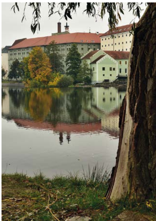
Písek, sladovna a městská elektrárna
