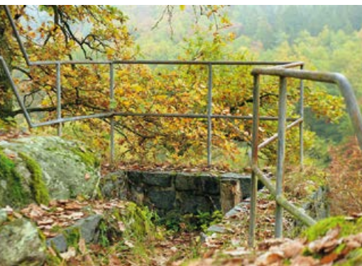
Vyhlídková zídka a zábradlí
