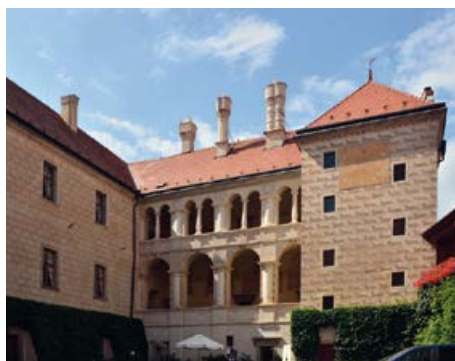
Severní křídlo mělnického zámku
