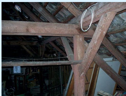
Původní konstrukce krovu brání vestavbě
