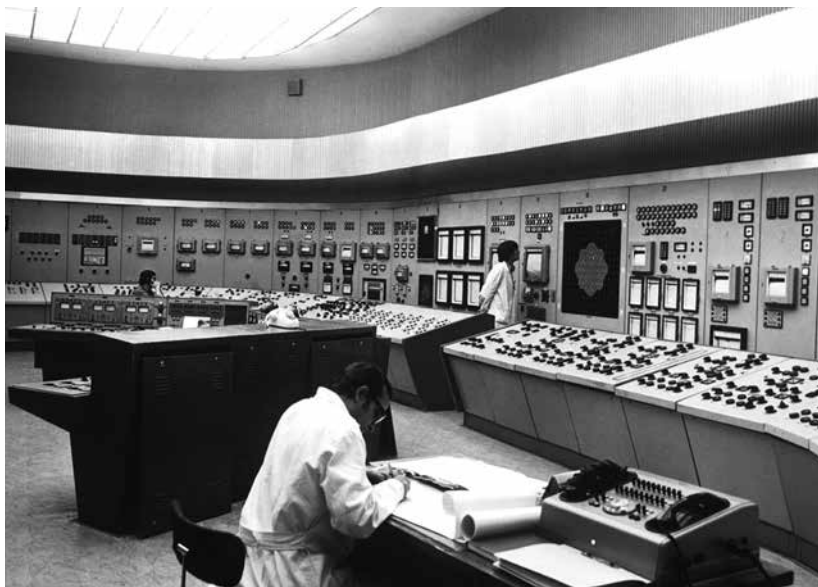
Na blokové dozorně nikdo nebyl. (Zdroj: inis.iaea.org)
