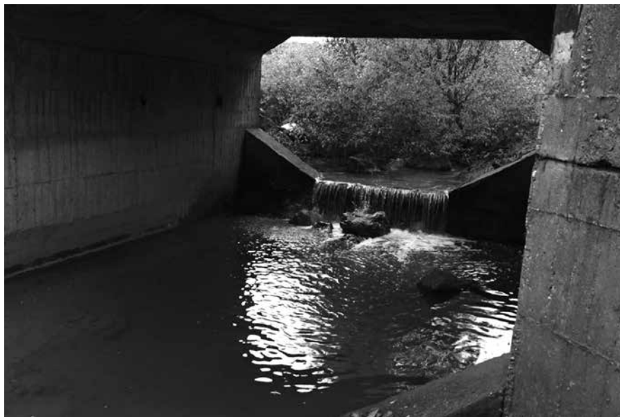
Most přes potok Manivier. (Foto: autor)
