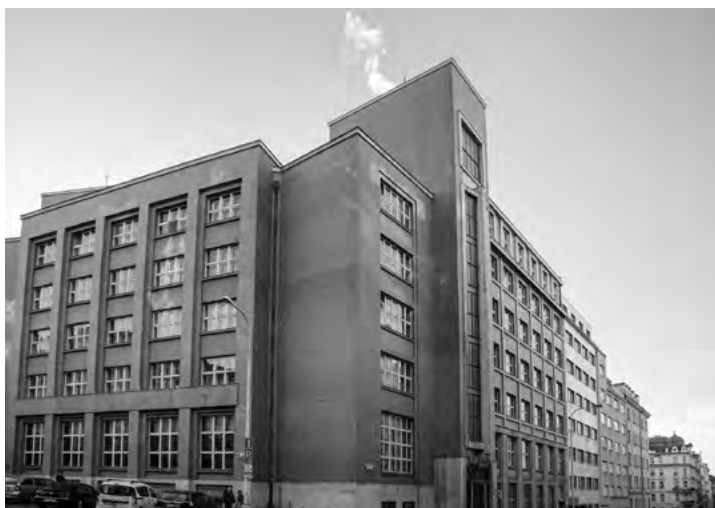
Dům Zemědělské osvěty, dílo Josefa Gočára, na křižovatce ulic Slezská, Blanická a Římská patří mezi pozoruhodné moderní vinohradské stavby z období první republiky. Byla dokončena v roce 1926 a reliéfy Otto Gutfreunda byly nad jeho portály instalovány o rok později.
